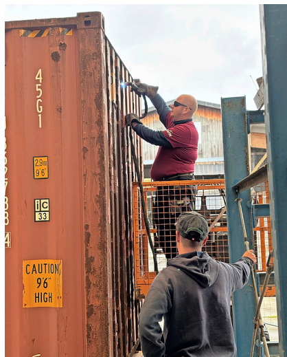
Der Container wird platziert und Lukas Hallauer schneidet die Fenster aus. (Bilder: Andreas Keller)
